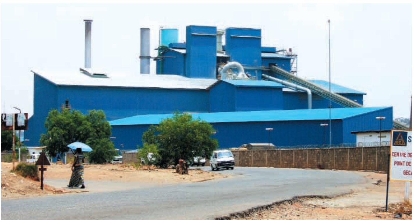
Usine de traitement du cuivre et du cobalt, Lubumbashi, novembre 2005.
